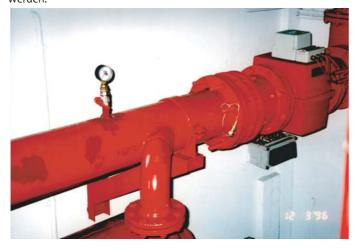
Beispiel hierfür ist ein häufig auftretender Messfehler bei Pumpwerken mit nachgeschaltetem MID. Eine Rückströmung aus der Förderleitung nach Ende des Pumpenganges – verursacht durch ein verzögert schließendes Rückschlagventil – wird von älteren MID ohne Fließumkehrerkennung als positive Fördermenge registriert.
