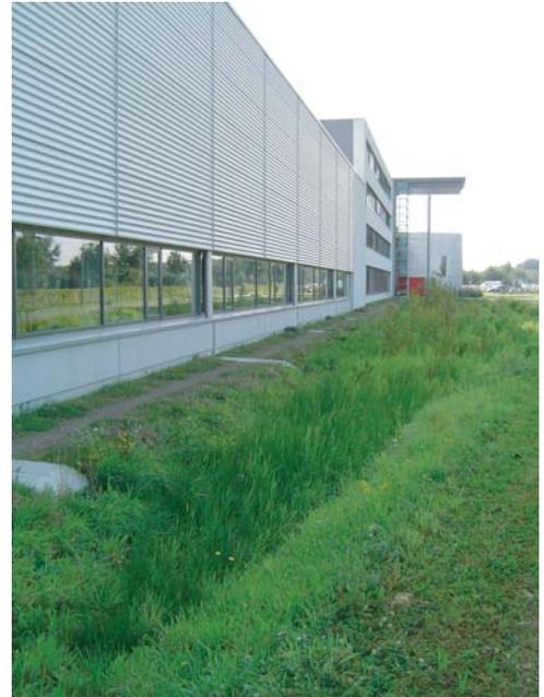
Anlage zur kombinierten Versickerung, Rückhaltung und Ableitung (PZH)
